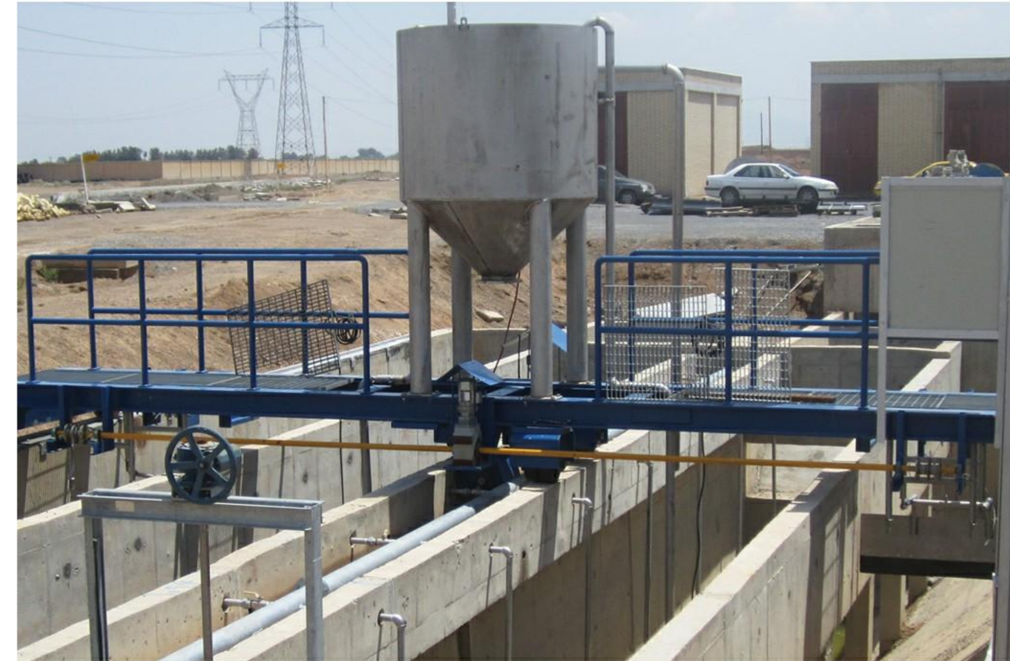
تصميم وإنشاء وتركيب جسور إزالة الحمأة والترسيب (مشروع تنقية مياه الصرف الصحي البلدية)
