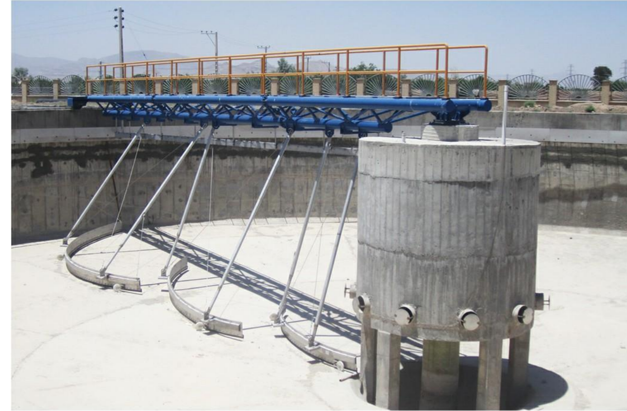
تصميم وإنشاء وتركيب جسور إزالة الحمأة والترسيب (مشروع تنقية مياه الصرف الصحي البلدية)
