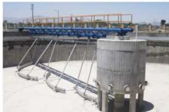
طراحی، ساخت و نصب انواع پل های لجن روب و ته نشینی (پروژه تصفیه خانه فاضلاب بهداشتی شهری)
