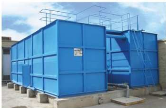
پکیج تصفیه فاضلاب صنعتی به ظرفیت ۸۰ مترمکعب در شبانه روز
