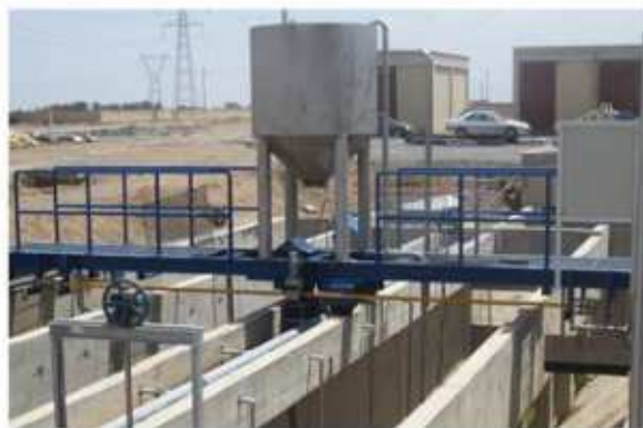
طراحی، ساخت و نصب انواع سیستم های آشغالگیری و دانه گیری (پروژه تصفیه خانه فاضلاب بهداشتی شهری)
